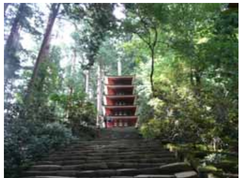
修復された 室生寺五重塔 15:19
