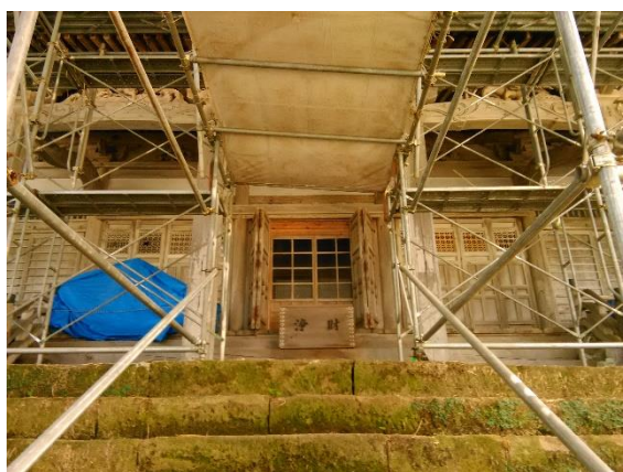
本堂正面 足場
