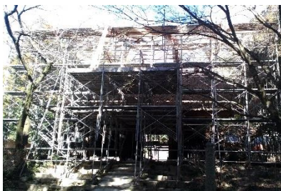
仁王門は修復工事中
