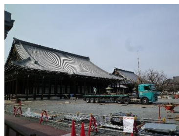
御影堂はまだ 工事が続いていた
