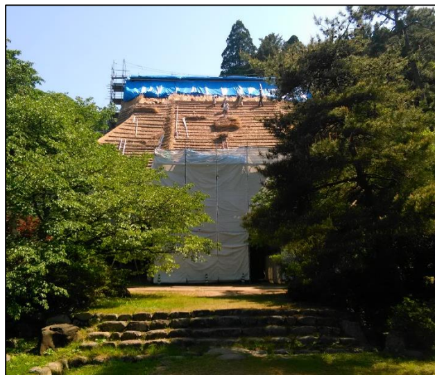
本堂の茅葺屋根、葺き替え工事中
