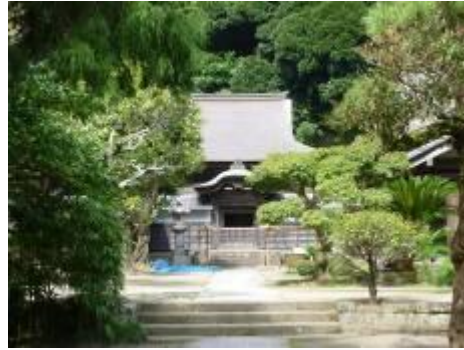
舎利殿は修理中
