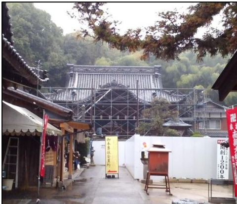
本堂（改修工事中）
