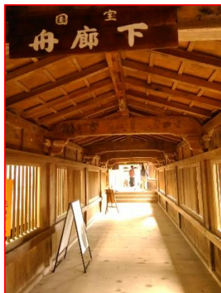
観音堂と神社を結ぶ船廊下
