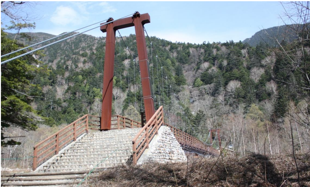
横尾大橋 (涸沢側から)
