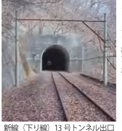
新線(下り線)13号トンネル出口
