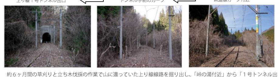
約6ヶ月間の草刈りと立ち木伐採の作業で山に還っていた上り線線路を掘り出し、「峠の湯付近」から「1号トンネル出口」まで歩けるようになりました。2019年3月には、上り線での廃線ウォークが開催されました。
